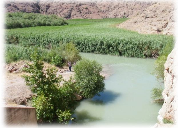
Medik Barajı (Malatya) rezervuarında sedimentasyon problemi
