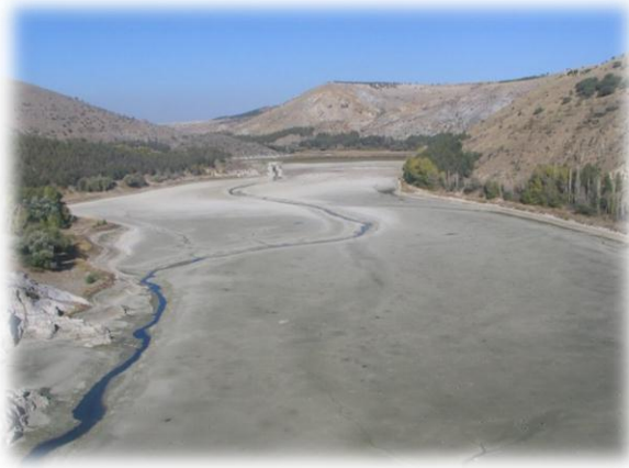
Çubuk 1 Barajı (Ankara) rezervuarında sedimentasyon problemi
