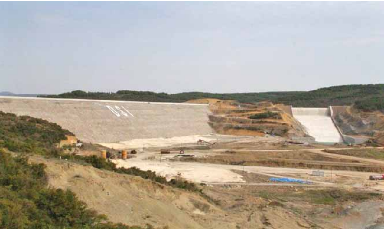
Çokal Barajı İnşaatı - Tekirdağ
