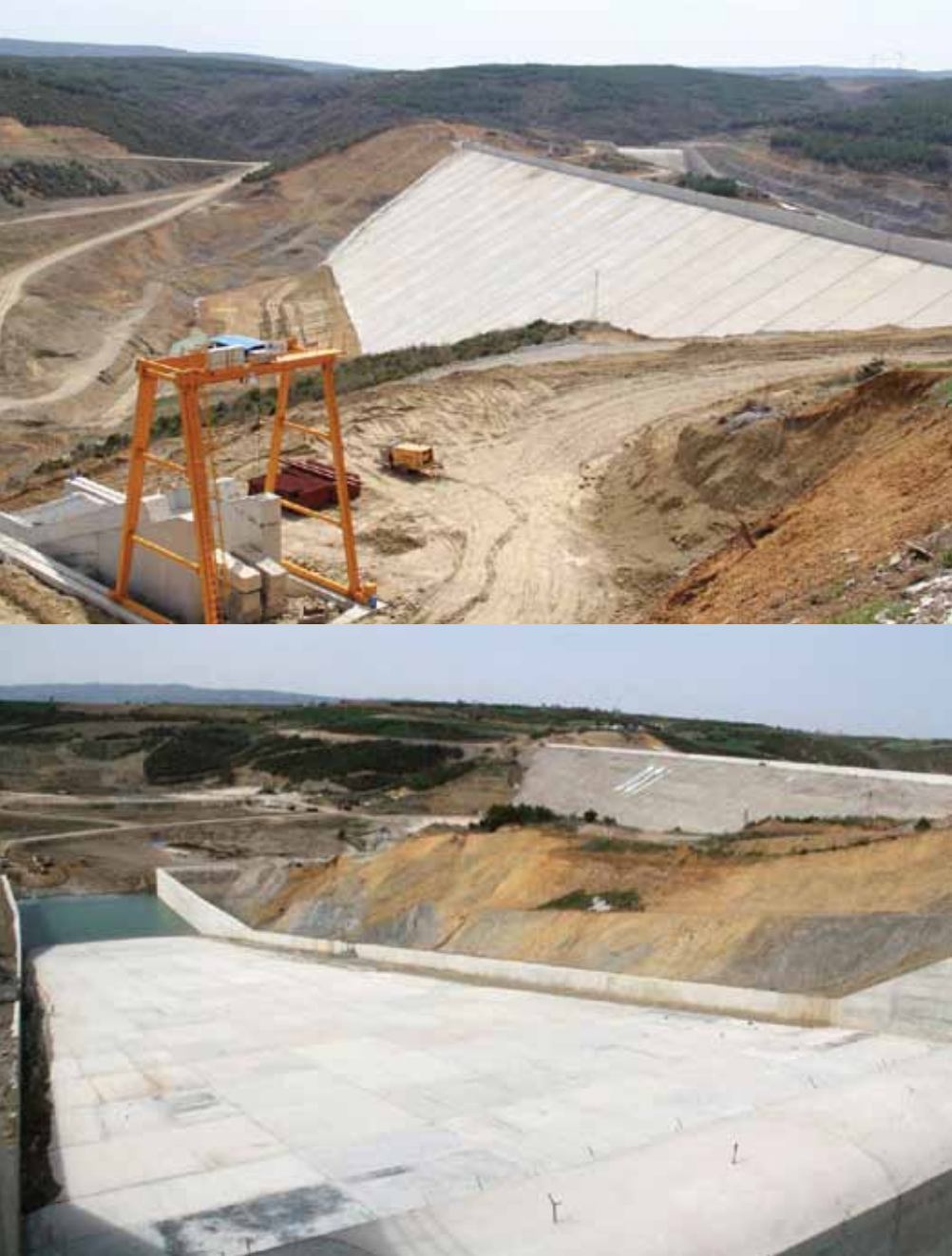
Çokal Barajı İnşaatı - Tekirdağ
