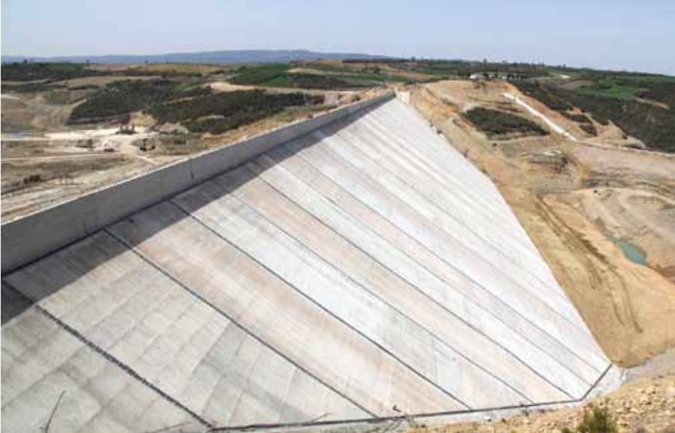
Çokal Barajı İnşaatı - Tekirdağ
