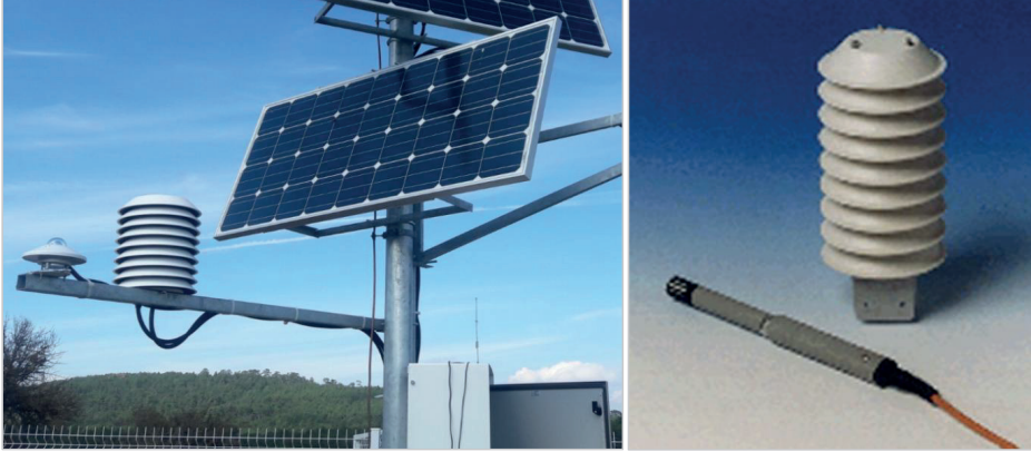
Şekil 10. Siper İçerisinde Sıcaklık Ölçümü
