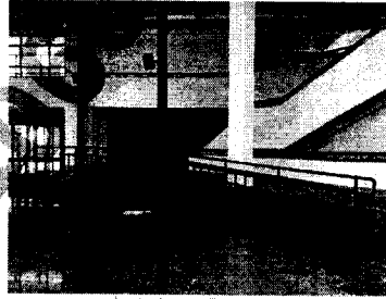
İç mekan fuaye engelli rampası imalatı
