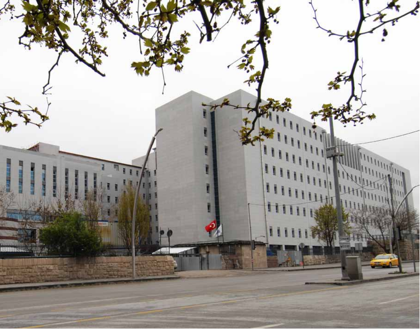
Halkla İlişkiler Binası (Dikmen Caddesinden görünüm)
