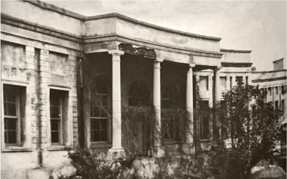
Dış Karakol binası, Anıtlar Kurulu Arşivi
