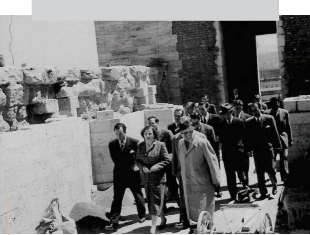
Bayındırlık Bakanı Kemal Zeytinoğlu'nun Anıtkabir inşaatındaki denetimi
