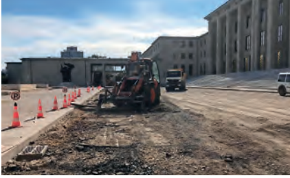
Bakım- Onarım Çalışmaları
