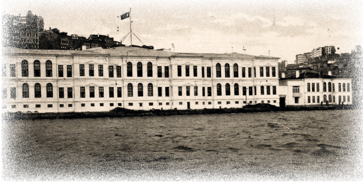
Fındıklı Meclis-i Mebûsan Binası
