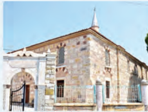
Fatih Camii 1531'de yapıldı Foça'nın Türk dönemine ait en önemli yapısı
